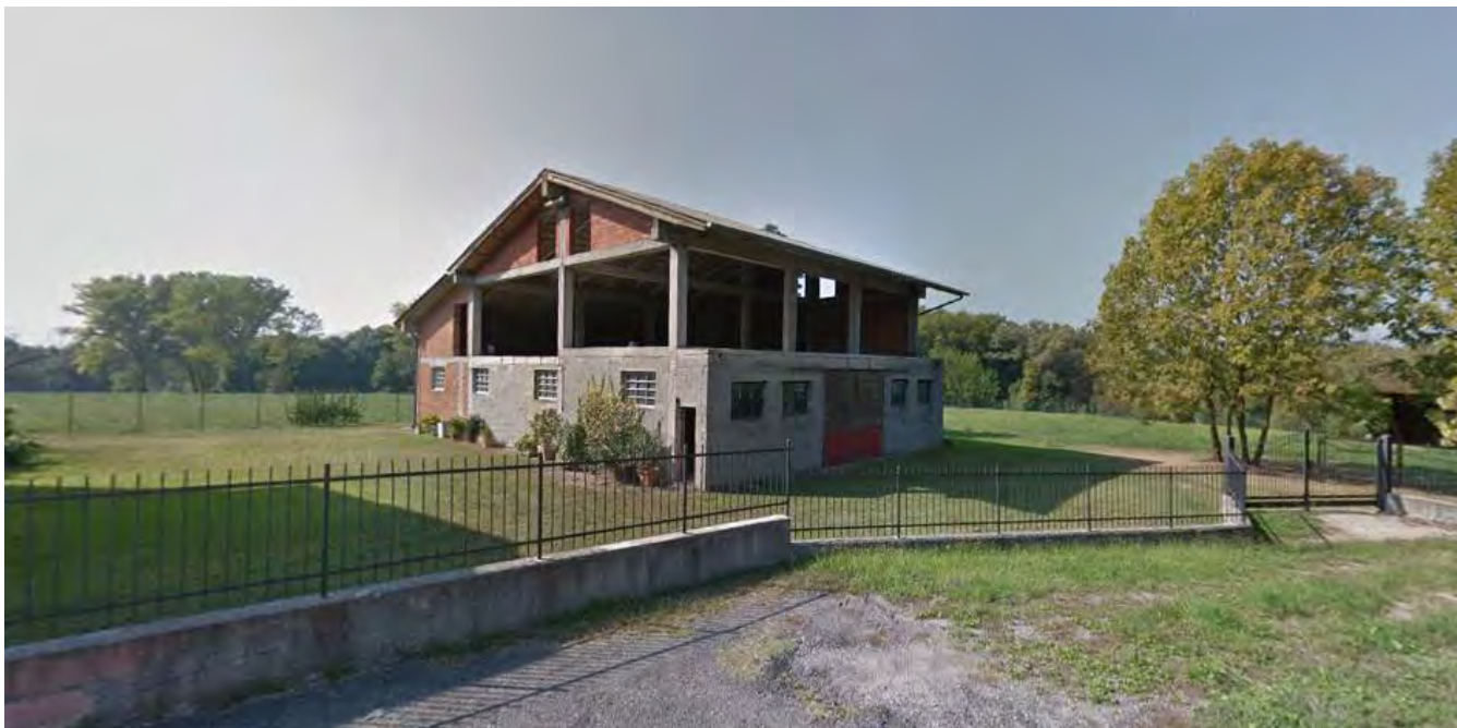
Figura 47 - Edificio da recuperare
