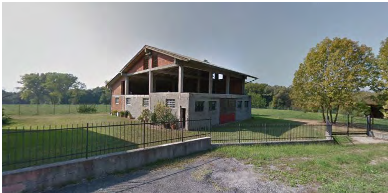
Figura 14 - Edificio da recuperare
